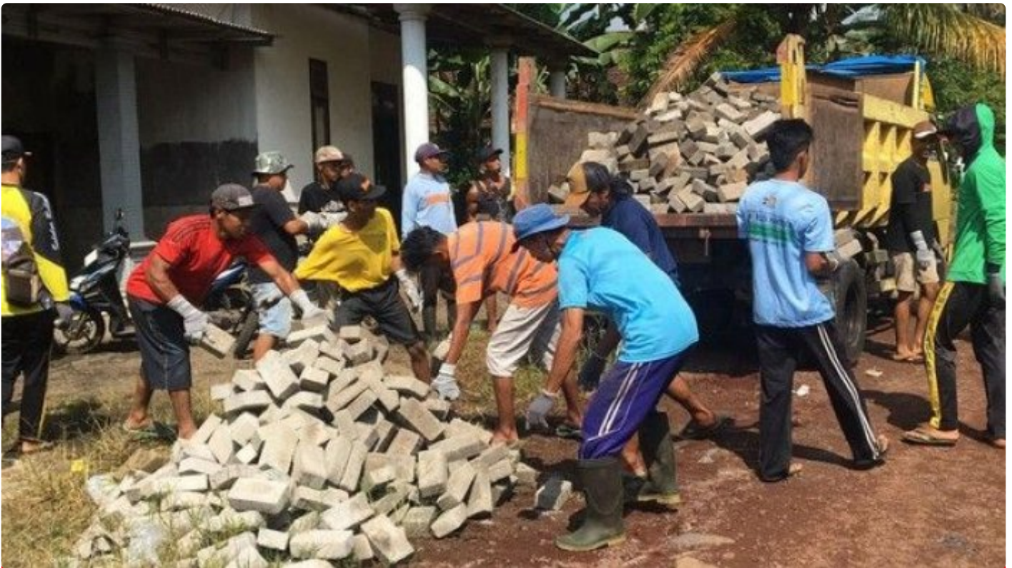
Paving block pemberian dari salah satu caleg yang kalah diangkut lagi menggunakan truk
